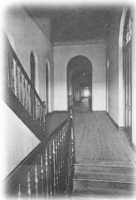
Entrada tomada do interior
